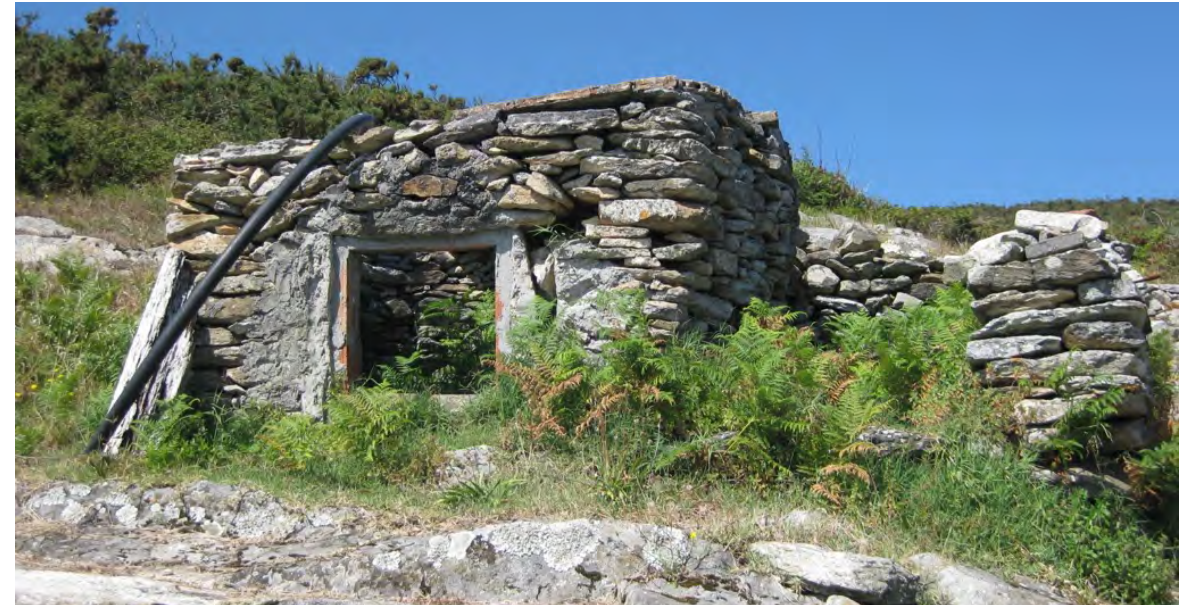
Cortello sobre un afloramento. Está feito con cachotería recollida na contorna.
